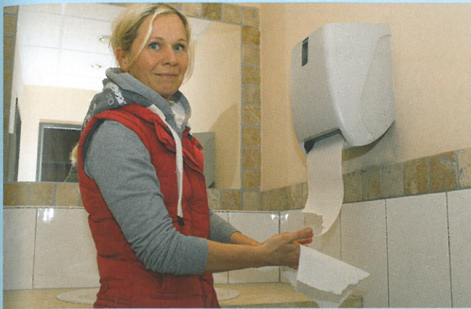
In den Sanitärräumen kommen berührungslos zu bedienende Spendersysteme zum Einsatz. Der Handtuchspender ist so konzipiert, dass nur das Papier berührt wird, das vom Nutzer entnommen wird. Ein Blatt reicht aus, um die Hände zu trocknen.
