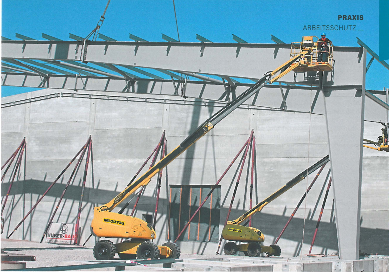
Persönliche Schutzausrüstung gegen Absturz (PSaGA) schützt die Person davor, aus dem Arbeitskorb herausgeschleudert zu werden.
